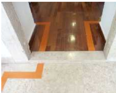
Fotografia 9 – BM Orlando Ribeiro: acessos no interior
