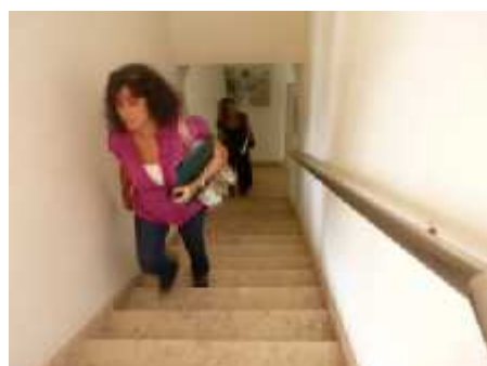
Fotografia 6 – BM Orlando Ribeiro: acessos no interior
